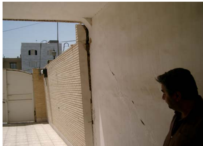
شکل ۳) نشست ساختمان و انحراف دیوار به علت نشست زمین
