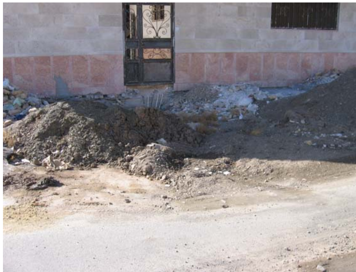
شکل ۲) نشست در سطح آسفالت خیابان اندیشه ۷۱/۶
