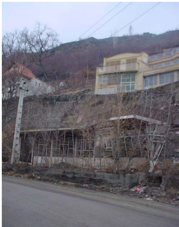
شکل (۲) بنای تخریب شده در پای شیب بر اثر حرکت دامنه.
