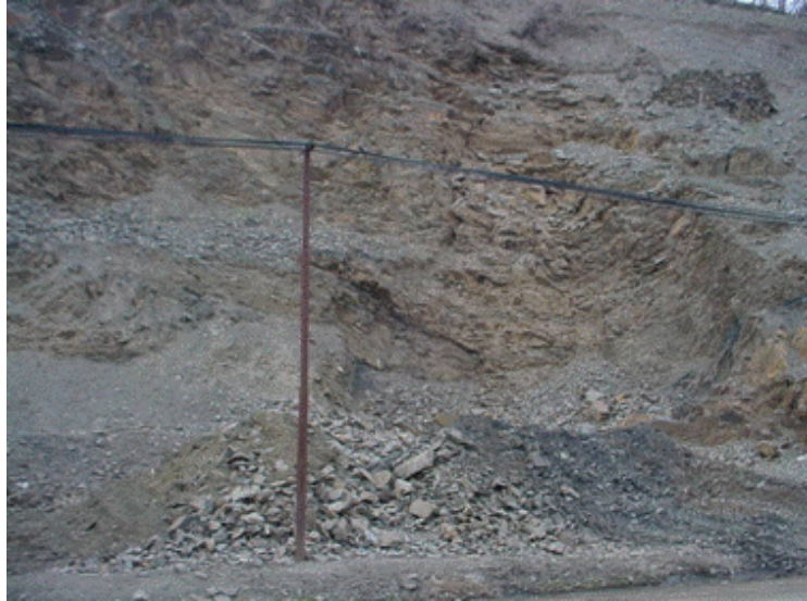
شکل (۱) برداشتن پای دامنه به منظور ایجاد فضا بیشتر برای ساخت و ساز.
