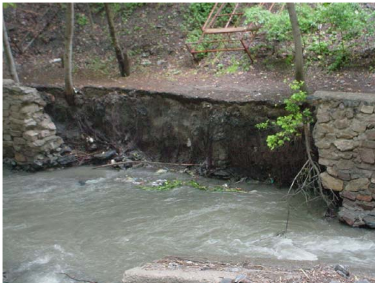
شکل ۵) کج شدن درختان و شکسته شدن دیوار حائل کنار رودخانه بر اثر حرکت دامنه.
