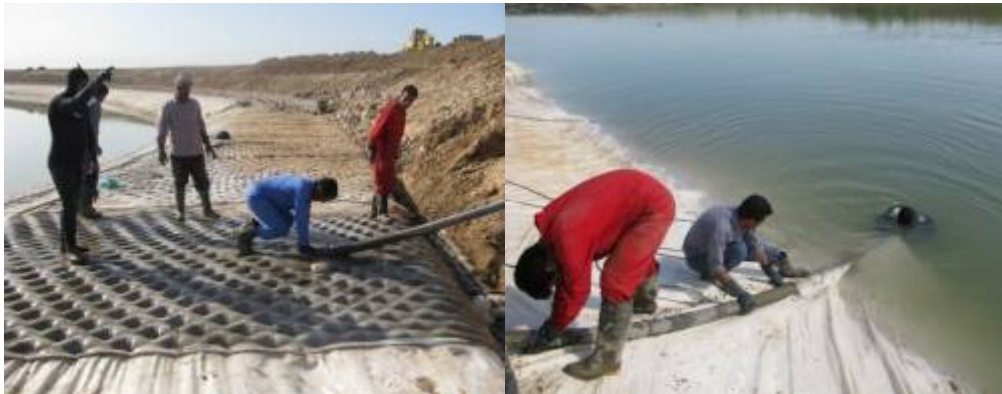
شکل ۶- تزریق بتن درون لحاف بتنی در زیر آب و خارج از آن.
