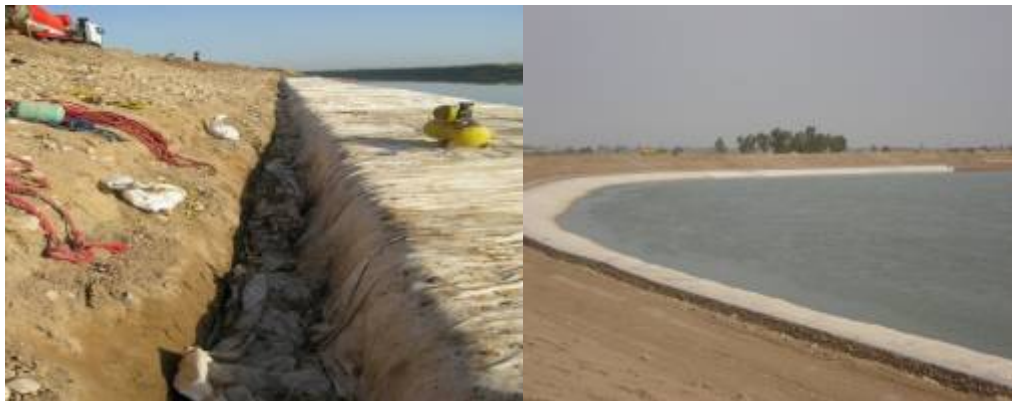
شکل ۳- نمایی از Weep Hole قبل و بعد از اجرای دیواره درون آن.
