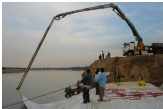
شکل ۵- استقرار فیلتر ژئوتکستایل و لحاف بتنی در بستر رودخانه.
