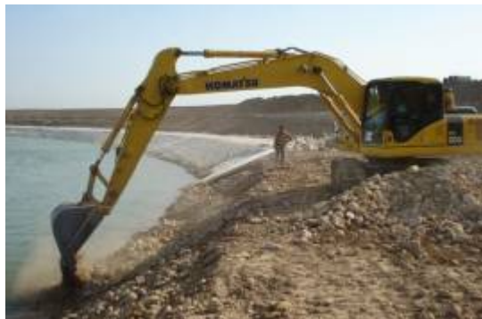
شکل ۴- مقاوم سازی زیر فیلتر غشایی (ژئوتکستایل) و لحاف بتنی در بستر رودخانه با قطعات سنگی در اندازه بولدر.
