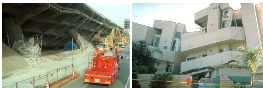
شکل ۳- نمونه‌ای از خرابی یک ساختمان در نورتریج و یک پل در کوبه پس از زلزله
