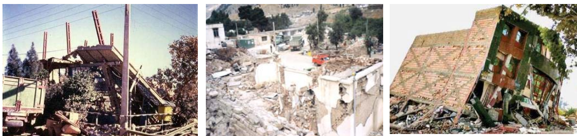
شکل ۱- نمایی از آثار زلزله‌های طبس، رودبار و بم
