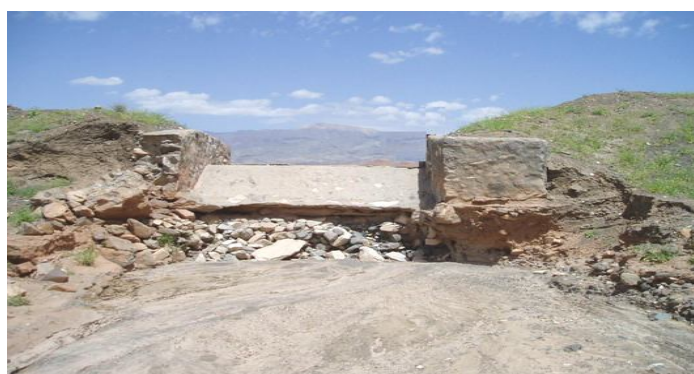
شکل 2: نمونه‌ای از دروازه‌های تخریب شده در یک کانال آبرسان-گسترشی
