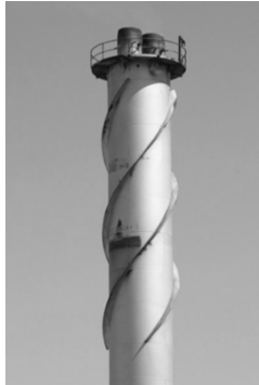
۲-د) - دودکش مجهز به تیغه‌های مارپیچ
