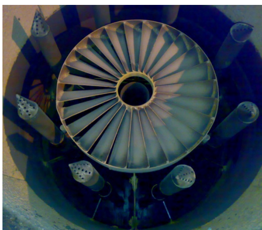
شکل ۲- تصویر نازل پاشش سوخت، کانال ورود هوا و تجهیزات نصب شده در آن
