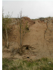
شکل 1- رویش درخت در برج آبگیر جناح راست
