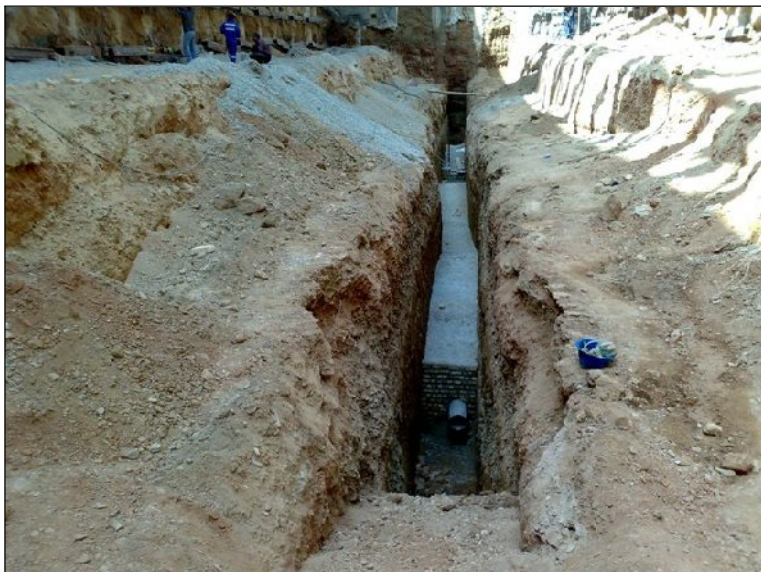
شکل (۵) - نمایی از کانال احداث شده در کف گود ایستگاه N7 به منظور زهکشی و پایین آوردن تراز آب زیرزمینی.
