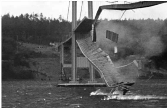
شکل ۲. فروپاشی پل تاکوما
