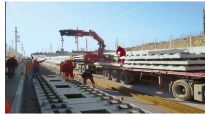
شکل شماره ۶- نقشه و مراحل اجرای اسلب تراک بروش OBB-PRR
