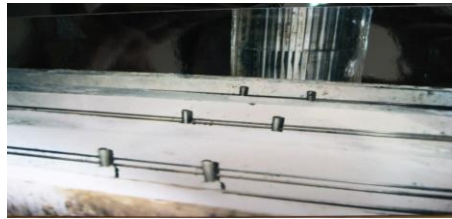
شکل شماره ۱۵- آماده سازی قالب و قرار دادن میلگرد
