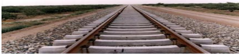
شکل ۱- تصویر روسازی کلاسیک اجرا شده یا روسازی بالاستی
