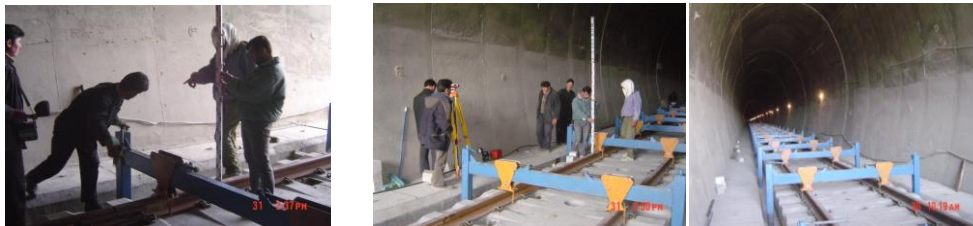
شکل ۱۹- اشکال بالاثبت کننده های قطعات بتن نسبت به اطراف را نشان میدهند
