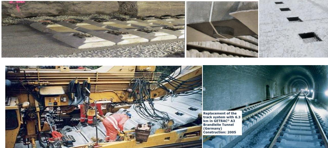
اشکال شماره ۸- نقشه و مراحل اجرای اسلب تراک بروش سیستم GE TRAC
