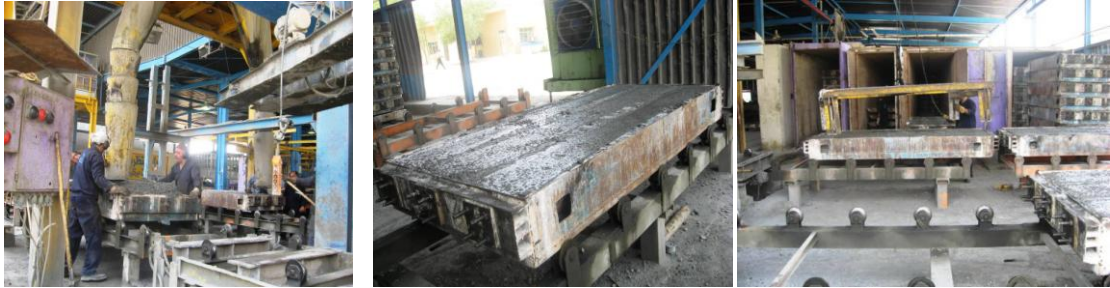
شکل ۱۶ - بتن ریزی قالب ها و عمل آوری با اتاقک بخار
