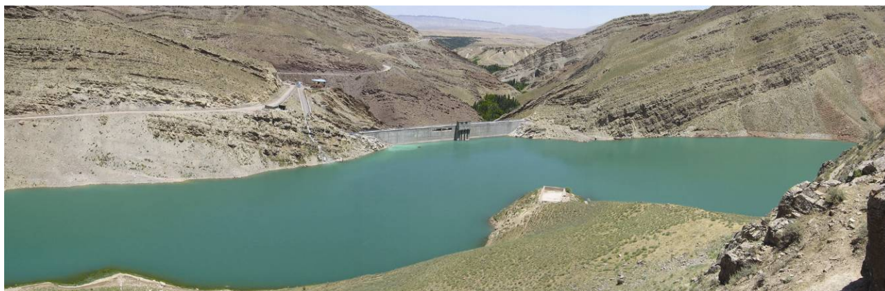
تصویر ۳- نمایی از وضعیت و شیب لایه‌ها در ساختگاه سد زاوین (دید به سمت شمال)
