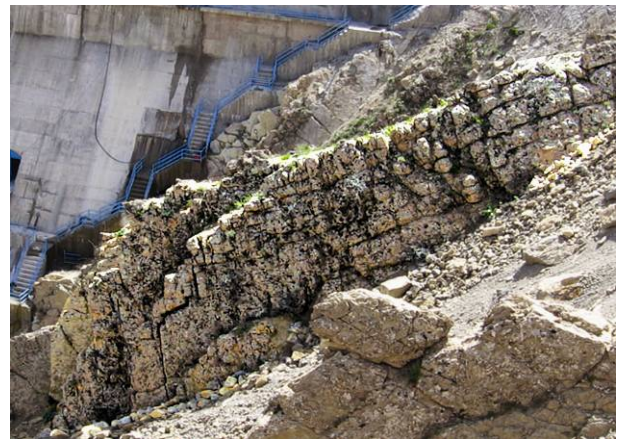
تصویر ۷- نمایی از وضعیت ناپیوستگی‌های ساختگاه سد زاوین (دید به سمت جنوب)
