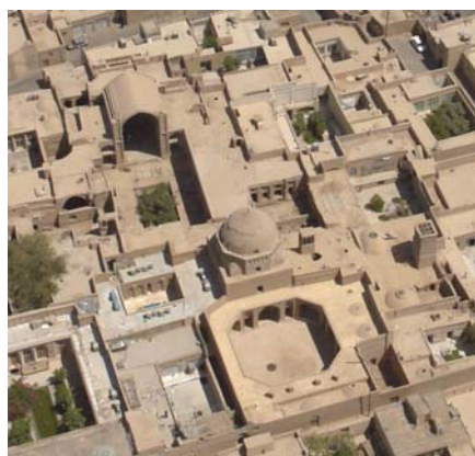
تصویر ۲. منظر هوایی حسینیه هشت و خانه طاق بلندها منبع: پایگاه میراث فرهنگی یزد.
