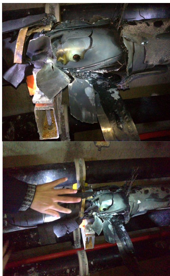
شکل ۶: کابل پس از خرابی
