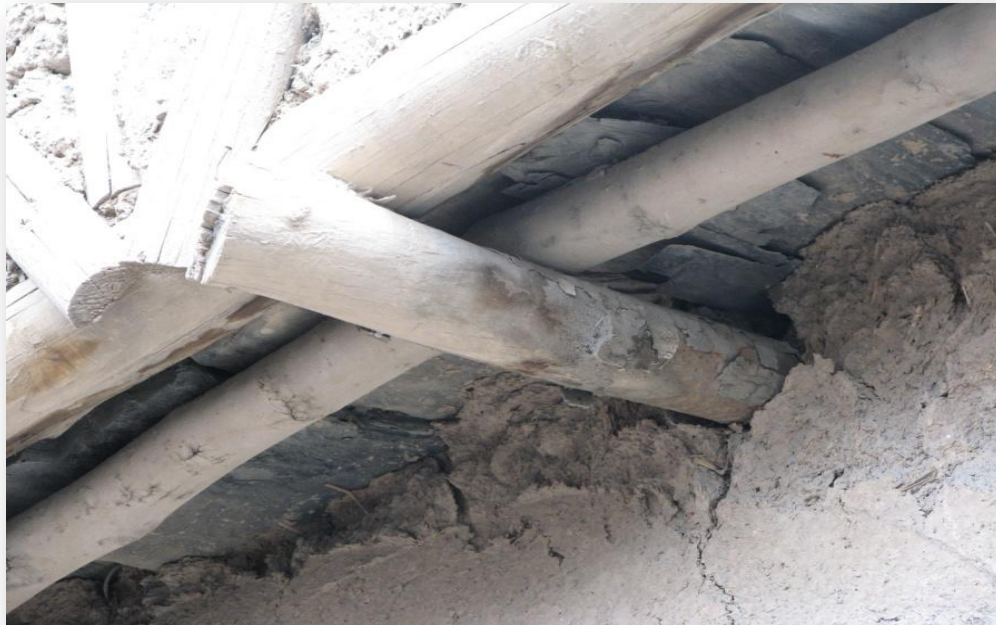
تصویر شماره ۴ نمای از یک سقف مسکونی روستای دهبار
