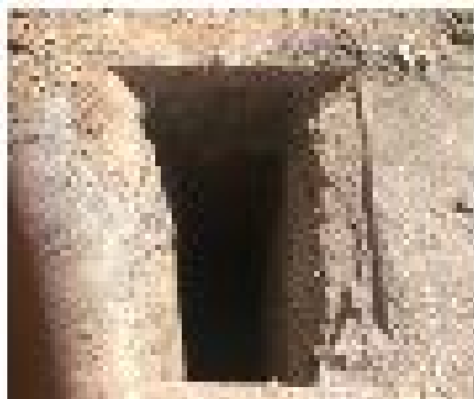
شکل ۵ - استفاده از خاکریز غرقابی (شفته گل) در مرمت ترانشه های تونلی
