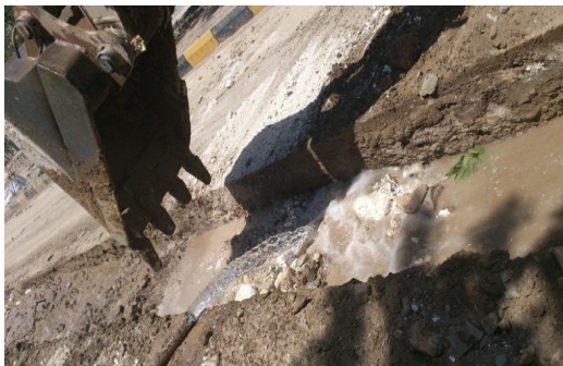
شکل ۲- استفاده شفته آهکی جهت ترمیم کانالهای حفاری شده در شهر مشهد
