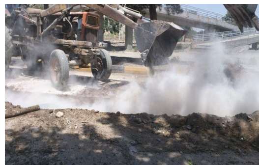
شکل ۲- استفاده شفته آهکی جهت ترمیم کانالهای حفاری شده در شهر مشهد
