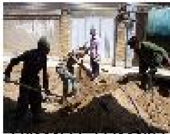
شکل ۵ - استفاده از خاکریز غرقابی (شفته گل) در مرمت ترانشه های تونلی
