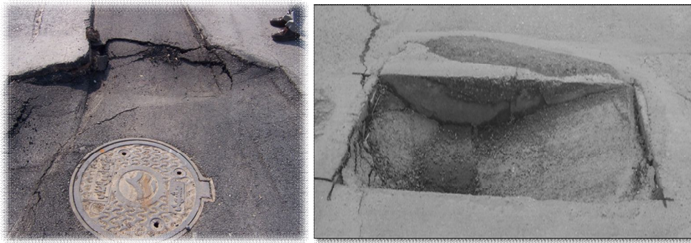
شکل ۶- نمونه ای از نشست در رویه آسفالتی
