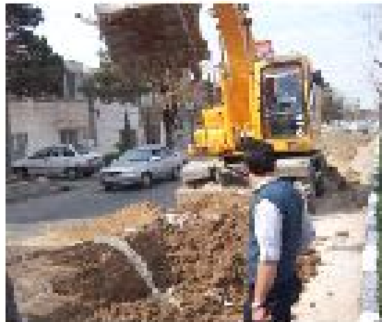
شکل ۴ - استفاده از خاکریز غرقابی (شفته گل) در مرمت ترانشه های طولی
