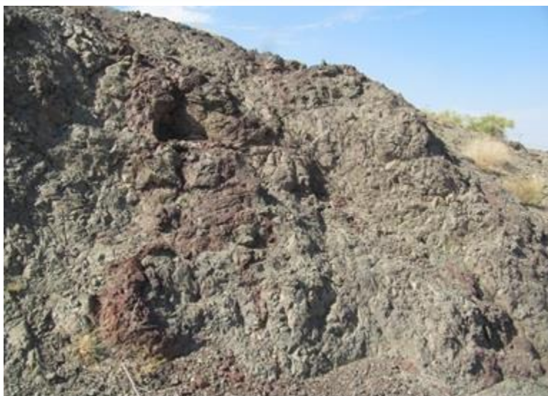
شکل (۴) شکستگی های تکیه گاه سمت راست
