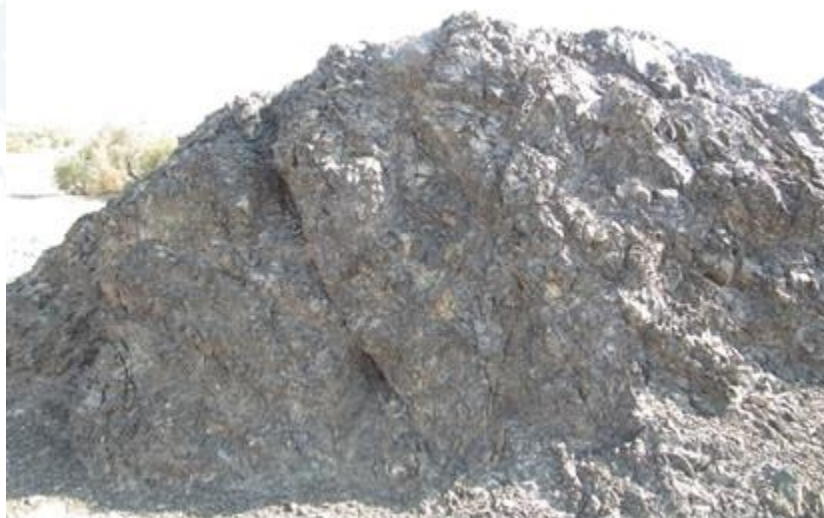
شکل (۵) شکستگی های تکیه گاه سمت چپ
