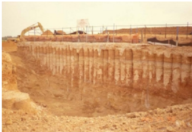
شکل 4- کاربرد روش اختلاط عمیق خاک در پایدارسازی دیواره گود
