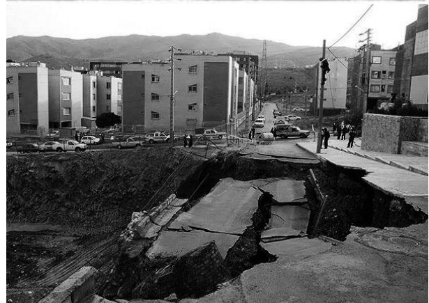
شکل ۱. بالا: نمونه ای از یک لغزش بزرگ انتقالی و تخریب یک مجتمع در حال ساخت در خیابان هاشمیه (سال ۱۳۸۵)؛ پایین: ریزش حاصل از گودبرداری در سنگ های اولترابازیک خیابان هاشمیه (سال ۱۳۹۲)
