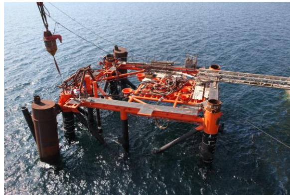
شکل ۲- عملیات نصب سکوی شابلونی فاز ۱۳ پارس جنوبی SPD ۱۳D
