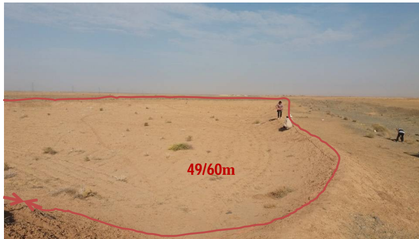
شکل 2. تصویر نحوه اندازه گیری طول بند سار نمونه واقع در دشت سر لخت
