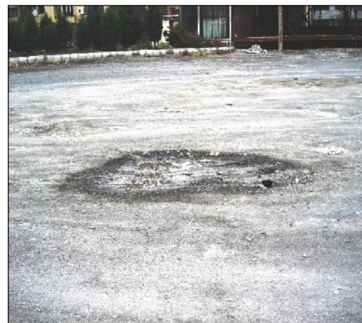
شکل ۵: قنوات بایر و دایر واقع شده در محدوده شهر مشهد س [16] و نشست دایره‌ای شکل در اسفالت خیابان در اثر ریزش میله قنات
