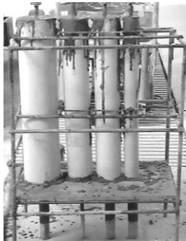
شکل (۶): تعدادی از نمونه‌ها در هنگام بتن‌ریزی
