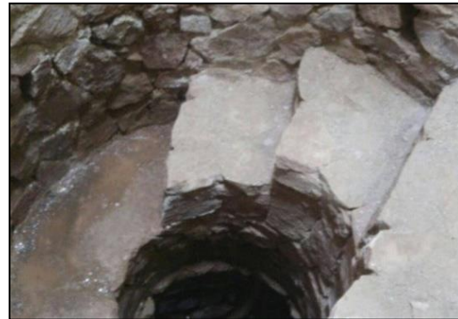
شکل ۲. یک حلقه چاه ورودی به قنات بلده
