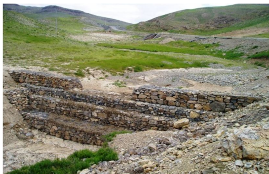
شکل 1- سازه سرریز گابیونی با رسوبات بالادست
