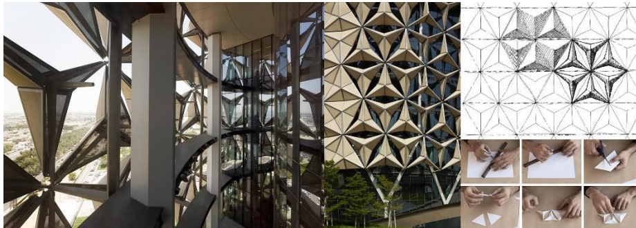
تصویر ۱۳: مدولهای باز و بسته شونده نما [17]
