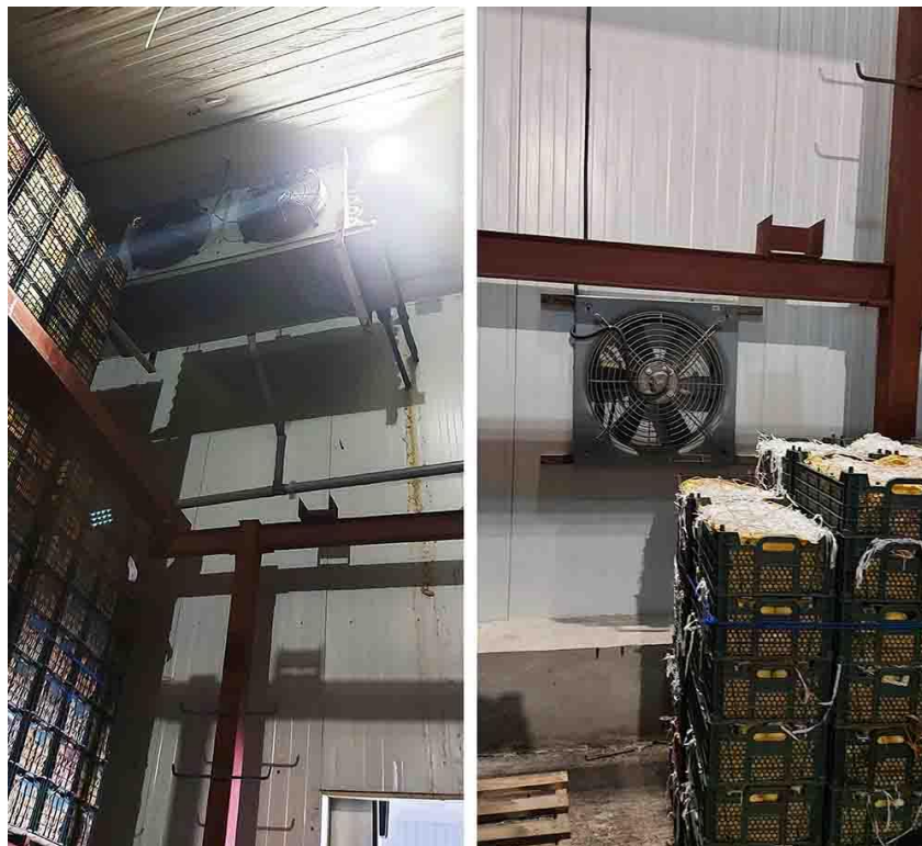
شکل-2: تصویر فن های تخلیه گاز و اواپراتور های نصب شده در سالن ها.
