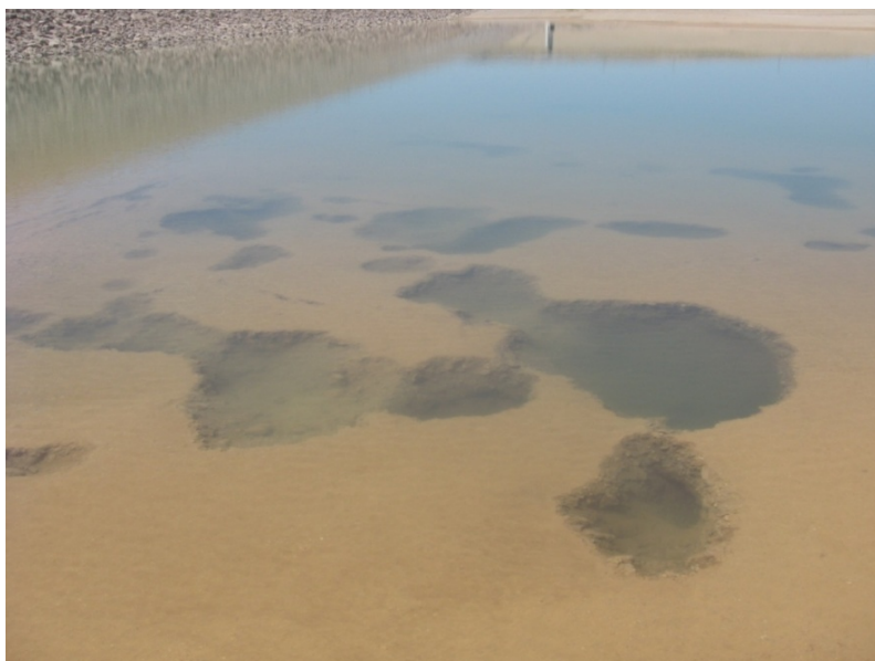
شکل ۴-فروچاله‌های مشاهده شده بعد از آبگیری
