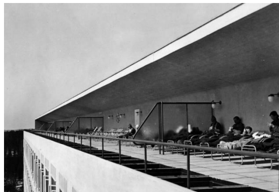
شکل ۳- استفاده از بام آسایشگاه پیمو (Sanatorium, 2021)
