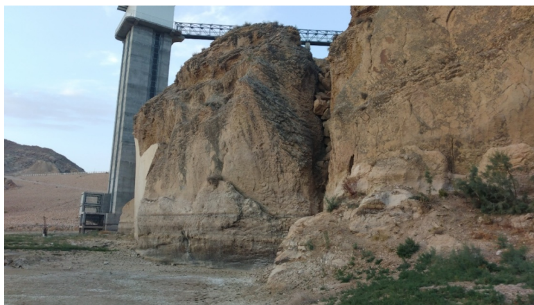
شکل ۵. درزه ها و شکستگی های جناح راست بالادست سد ابیورد (جهت دید به سمت شمال)
