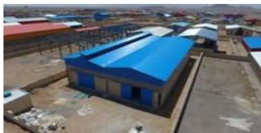
شکل (۷) - سقف کارخانه مهدیس از جنس ورق گالوانیزه
