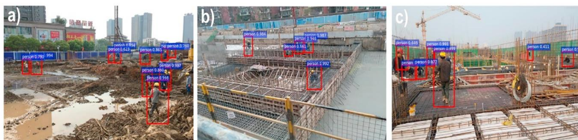
شکل ۵: شناسایی کارگران بوسیله بینایی ماشین و الگوریتم‌های یادگیری عمیق
