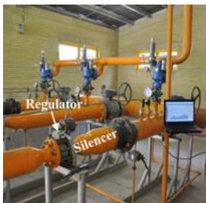
شکل ۱: صداخفه‌کن (سایلنسر) در مسیر نصب شده در پایین دست رگولاتور [۲]
