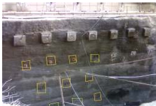
شکل ۶ - تصویر یکی از دیواره های گودبرداری، محل پت های فلزی و کابل های درون گمانه ها مشخص شده است
