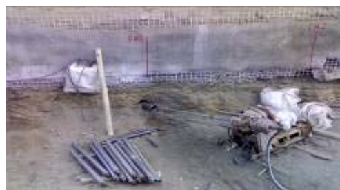
شکل ۷ - تصاویر (a) مش گذاری اولیه، حفر گمانه و استفاده از Casing در آن (b) شیر کنترل سیستم تزریق
