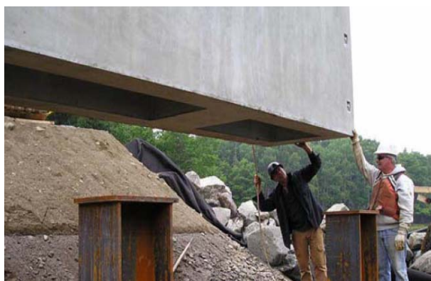
شکل ۲- پایه پل - مقاطع فولادی I شکل [2]
