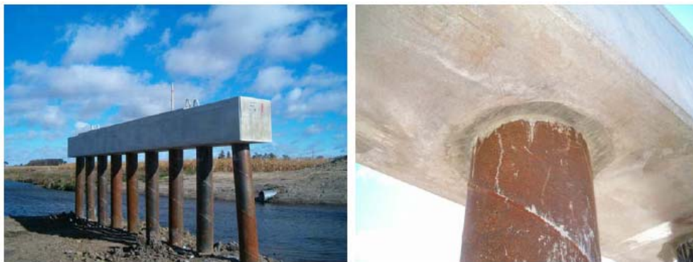
شکل ۱- سرستون پایه های فولادی [1]
